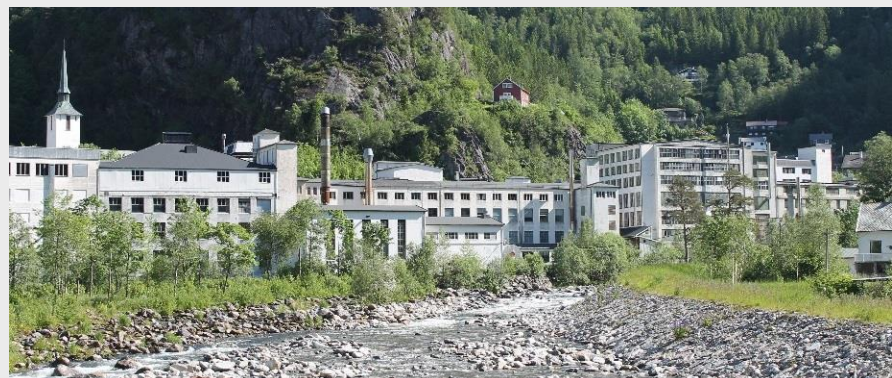
Bilde 1: Den eldre delen av industrianlegga i Dale.
