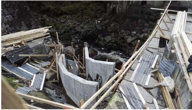
Figure 48. Bygging av fisketrapp i Kringsdalsstemma hausten 2018. Foto: Lars Johan Fjelde
