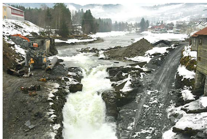
Figur 35 Bildet t.v. viser Palmafossen kraftverk i 2018. Til høgre viser ferdig riving av kraftstasjon og demning 23.2.2019. Det var eit elvekraftverk som utnytta eit fall på 14 meter i Raundalselvi i Voss. Det var bygd i 1919 med ein effekt på 0,31 MW og årsproduksjon er på 1,8 GWh. Det er i 2019 planlagt ei oppgradering av det eksisterande som vil bestå i ein ny dam og eit nytt kraftverk, begge deler lokalisert om lag som i dag, med en ny inntakskanal i samme trase som eksisterande inntaksrøyr. Dette vil gje ei tidobling av energiproduksjonen. Laksetrappa frå 1950-åra viser til høgre på bildet. Denne vil verta fornya med nytt anlegg og truleg gje betre vandringsstilhøve for anadrom fisk.
