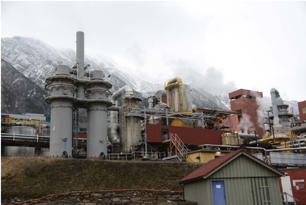
Figure 10: Boliden Odda AS (tidligere Norzink og Outokumpu Norzink) er ein produsent av sink og aluminiumfluorid med fabrikk på Eitrheimsneset i Odda. Fabrikken produserer også svovelsyre og anhydritt. Rensa avløpsvatn frå fabrikken går ut i Sør fjorden ved Odda. Tidlegare tider var det ikkje så strenge krav til utsleppa, så det ligg «Gamle synder» med miljøgifter i slamlaget på botnen.
