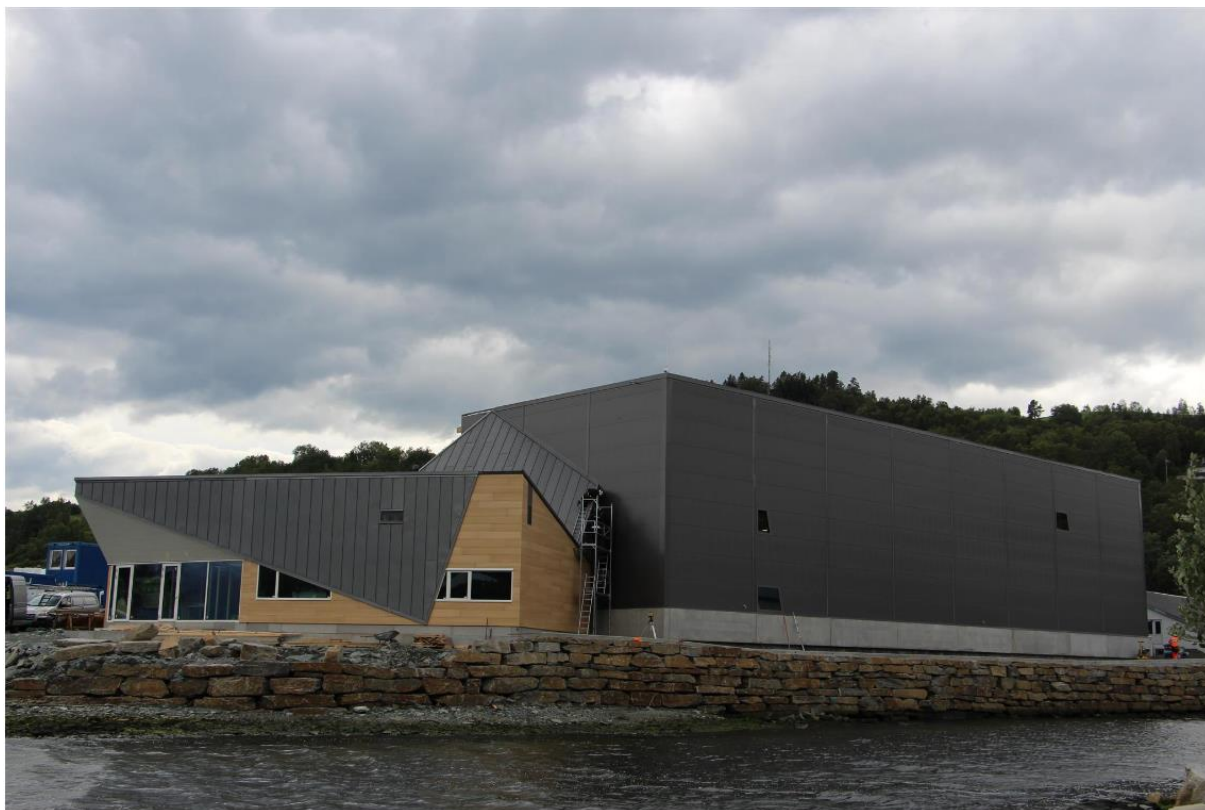
Nytt reinseanlegg på Notaneset i Øystese. Foto: Øyvind Strømmen / Kvam kommune
