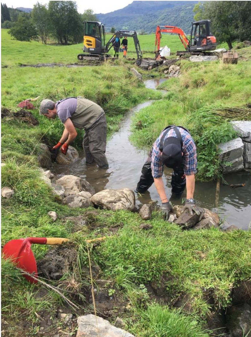
Restaurering av Gauro. Foto: Per Morten Ådland
