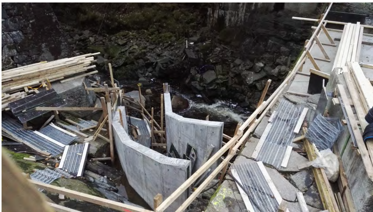
Figure 28. Bygging av fisketrapp i Kringsdalsstemma hausten 2018. Foto: Lars Johan Fjelde
