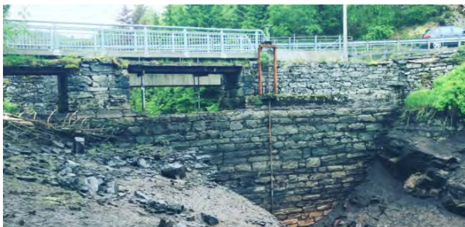
Figure 29. Nedtappa Kringsdalsstemme i 2018. Foto: Venstre.no
