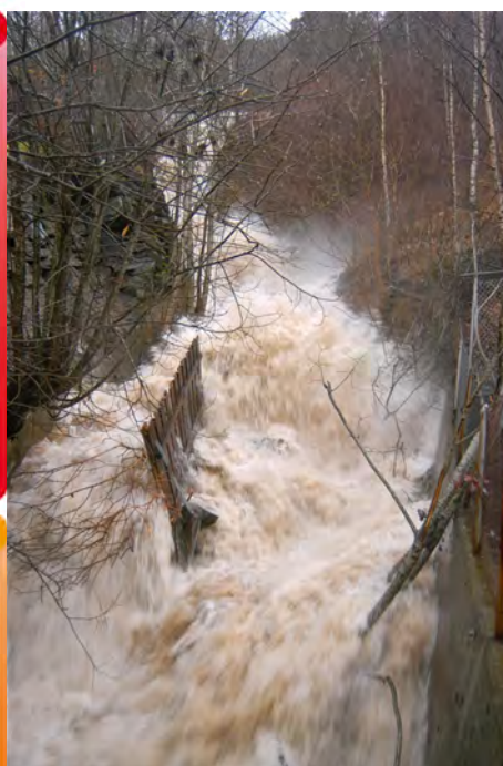
Foto: Vossavassdraget vart kraftig påverka av flaumen i oktober 2014. Det var skade på bygningar og infratraktur på mange hundre millionar kr.
