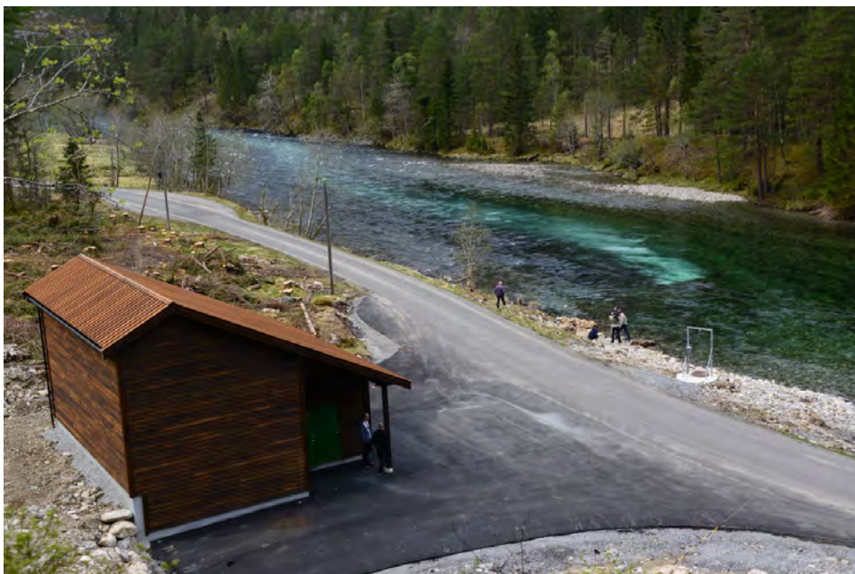
Figur 27. Modalen kalkingsanlegg med ei grønkvit stripe av kalkslurry ute i elva.
