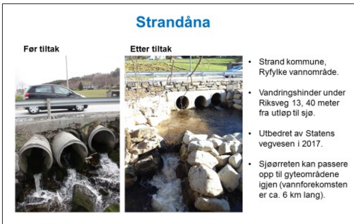
Figur 20: Viser eksempel på fjerning av vandringshinder for fisk. Statens vegvesen utbedret i 2017 kulverten hvor Strandåna renner under Riksveg 13. Sjøørreten kan nå passere opp til gyteområdene igjen og en 6 km lang bekkestrekning er nå lettere tilgjengelig for fisken igjen. Foto: Vegard Næss
