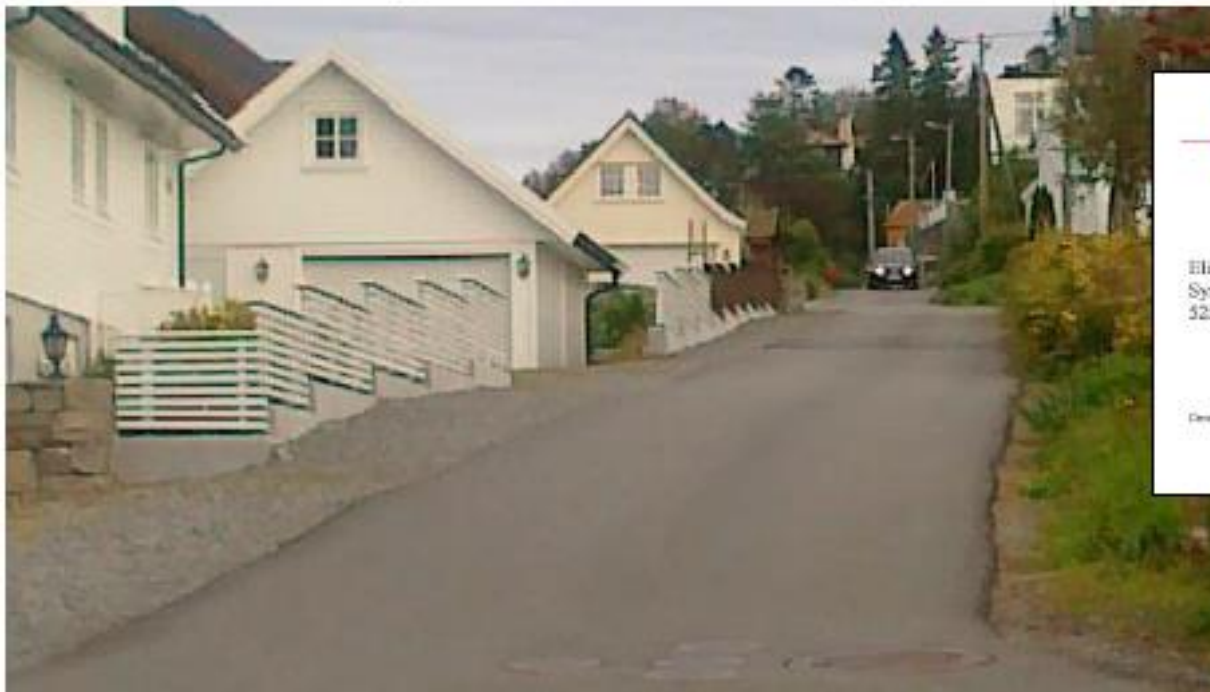
Punkttiltak: Ferdigstilling av fortau og møteplasser
