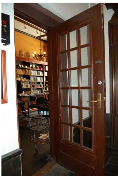
Dør frå butikklokalet til trappehallen
