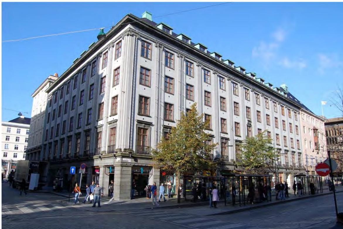
Olav Kyrres gate 1, eksteriør sett frå sør (Rådhusgaten til v., Olav Kyrres gate til h.)
