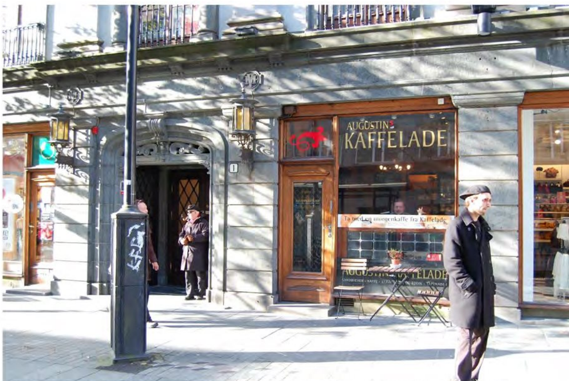
Detalj av fasaden mot Olav Kyrres gate (hovudinggang til v., Reimers & Sønns Eff. til h.)
