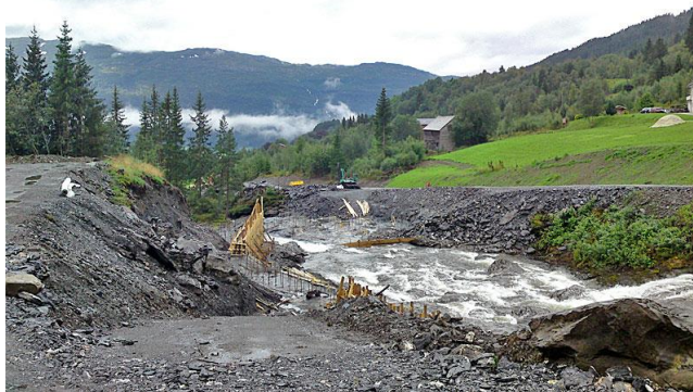
Frå arbeidet med kraftutbygging i Dyrvo (foto G.Bergo)
