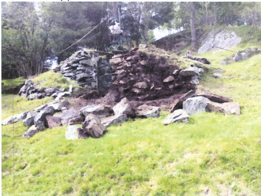
Demontering høyre yttermur
