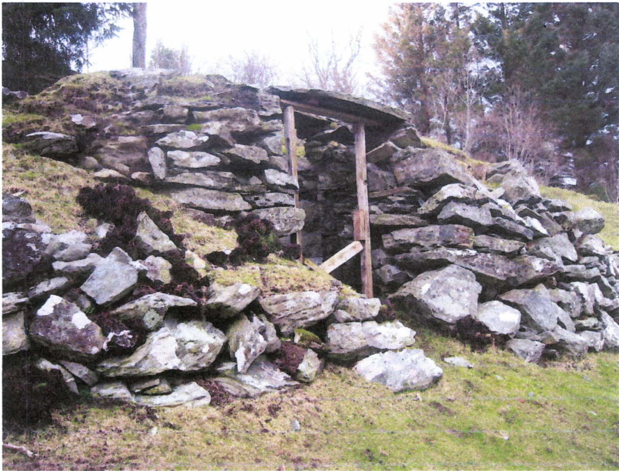
Status før oppstart.
