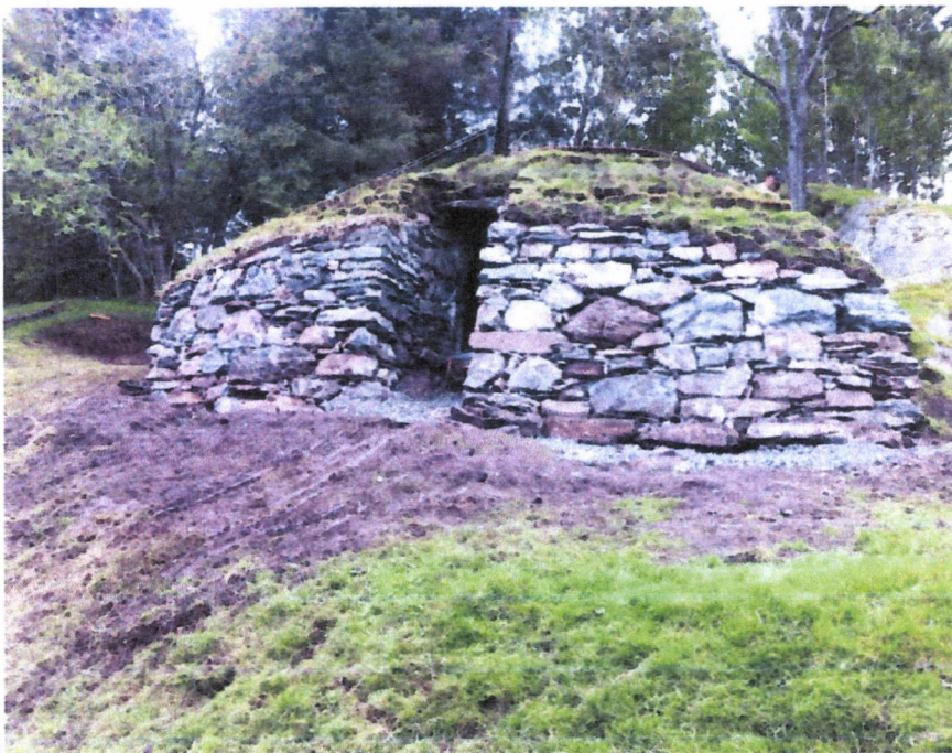
Jordkjellaren ferdigstilt fredag, 05.september 2014
