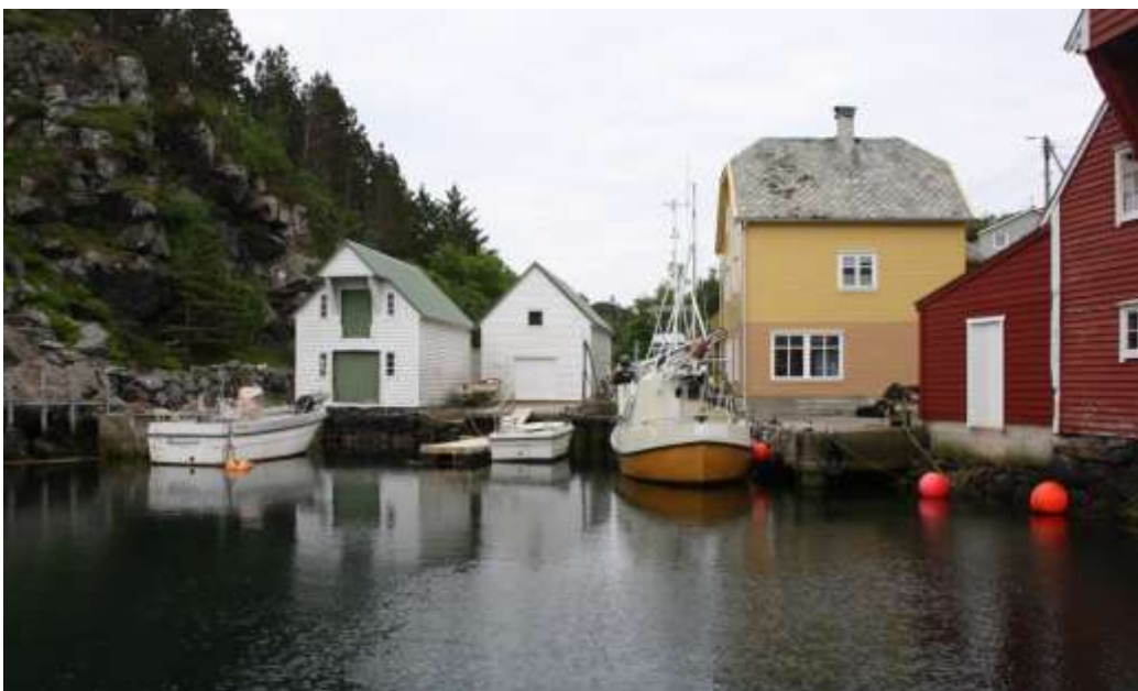
Figur 19. I dette sjøbruksmiljøet frå Stolmen, ser ein dei klassiske sjøhusa som ikkje var bygde for å huse båten men for lasting og lossing av varer og reisskap. Desse sjøhusa har utstikkande gavnl med vindehjul for lossing og lasting.
