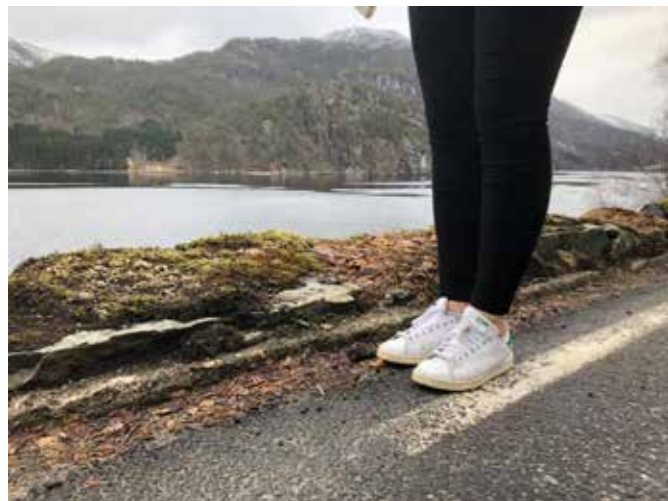
Slik ser vegsikringa ut der ein bil tippa over vegkanten 25. mars i år. Det er eit godt stykke att til 60 cm som Vegvesenet sjølv reknar som forsvarleg høgde på slike stader. Like ved sida av manglar kanten heilt.
