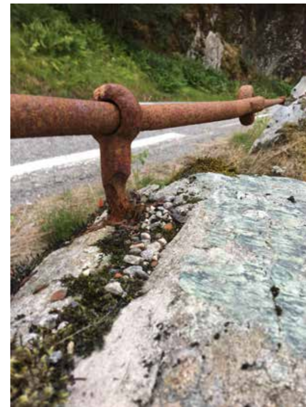
Dei gamle, smidde stålstengene som bind saman stabbesteinane er kanskje blant detaljane som har vore med å gje fv 569 vernestatus. Per i dag fungerer dei dårleg, både som rekkverk og forsterking. Verneverdien er vel også tvilsam...
