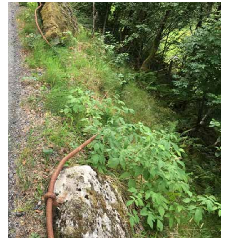
Dei gamle, smidde stålstengene som bind saman stabbesteinane er kanskje blant detaljane som har vore med å gje fv 569 vernestatus. Per i dag fungerer dei dårleg, både som rekkverk og forsterking. Verneverdien er vel også tvilsam...
