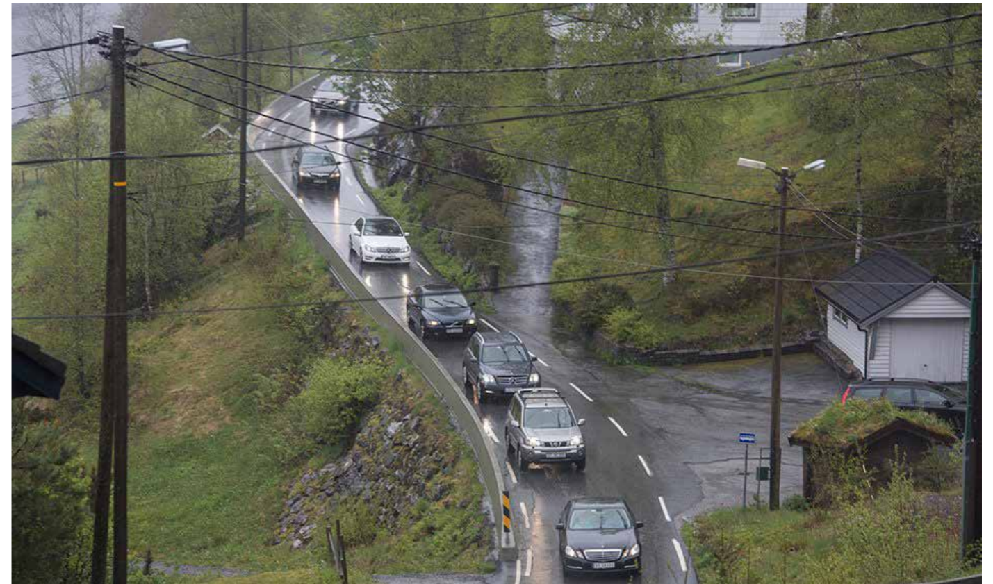
Bileta på dette oppslaget syner kva som skjer når fv 569 vert utsett for trafikk som han ikkje er dimensjonert for. Dette skjer med jamne mellom på grunn av vegstenging på E6.
