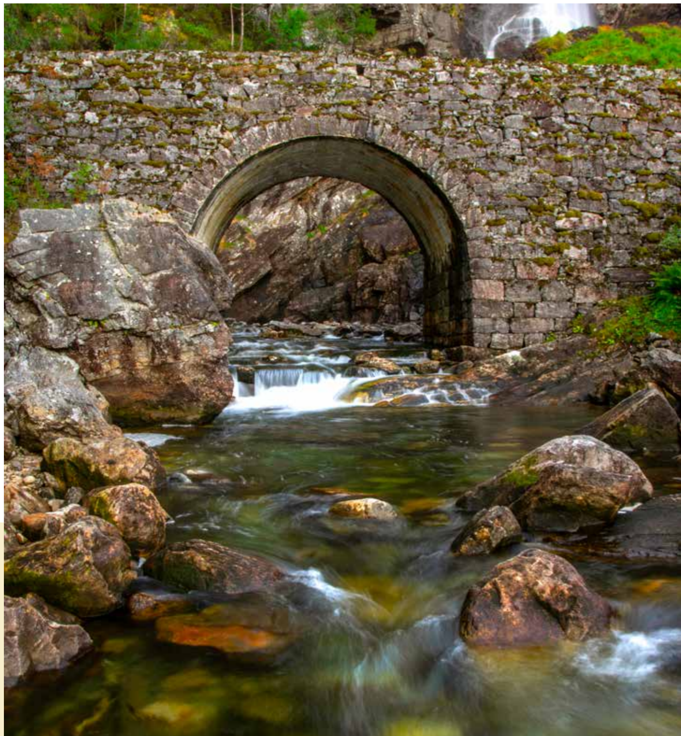
Den mektige kvelvebrua framfor Hesjedalsfossen er framleis eit imponerende syn frå sjøsida...
