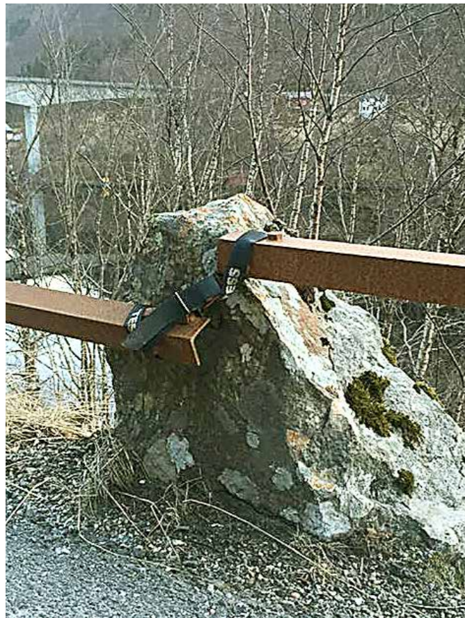
Entreprenøren har fått beskjed om å sikra alle spissar og endar på rekkverka mellom stabbesteinane. På dette punktet kan dei nok melde attende at oppdraget er utført...
