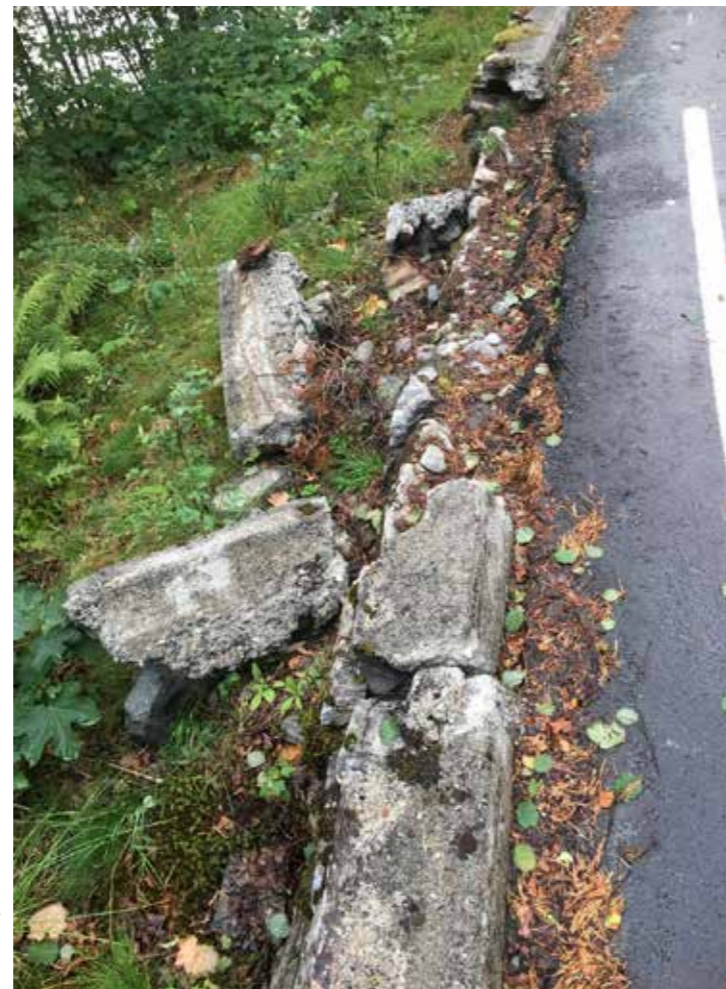
Slik ser vegsikringa ut der ein bil tippa over vegkanten 25. mars i år. Det er eit godt stykke att til 60 cm som Vegvesenet sjølv reknar som forsvarleg høgde på slike stader. Like ved sida av manglar kanten heilt.
