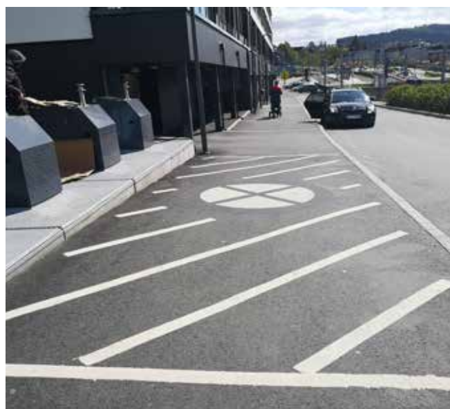
Fra Råstølen. Oppstillingsplass for kranbil på fortau. Varelevering og kunder til butikk parkerer også opp markert areal på fortau.
