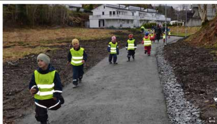
Bymiljøetaten arbeider med å oppgradere og lage nye snarveier til Bybane. Bildet er fra markeringen av oppgradert snarvei på Skjold 27. april 2018. Bilde: Anne Kringstad
