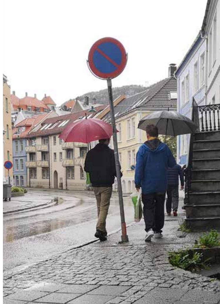
Foto: skilt plassert midt i ferdssonen, noe som medfører at fotgjengere kan bli tvunget ut i veibanen.
