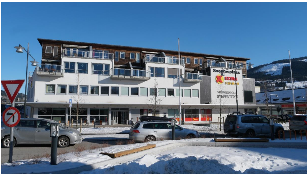
Nybygg ved Sverres plass
