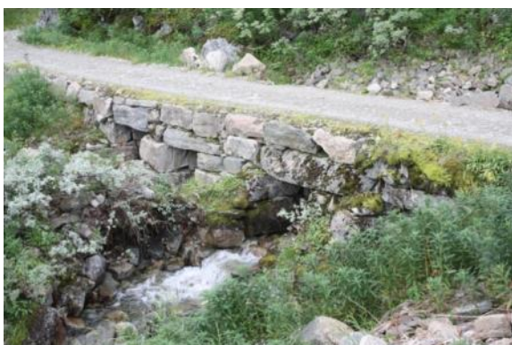
Tv: Rehabiliterert stikkrenne.
