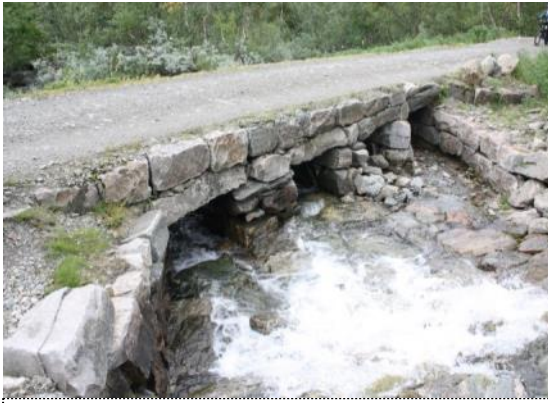
Tv: Restaurert stikkrenne.
