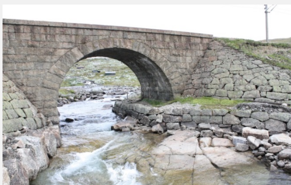
Element nr. 1 Bru over Finseåa
