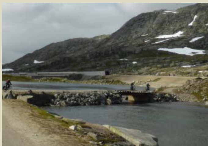
Element nr.14: Bru ved Lågheller
