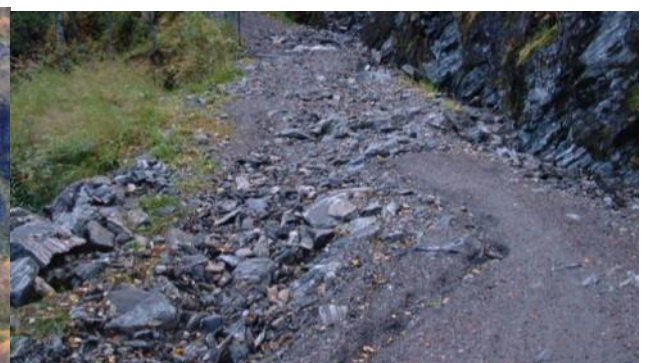
Th: Før rehabilitering.
