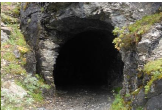
Th: Tunnelen under banen ved Kleven bru
