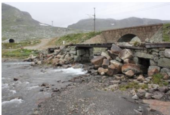
Tv: Bru over Finseåa 2010 .
