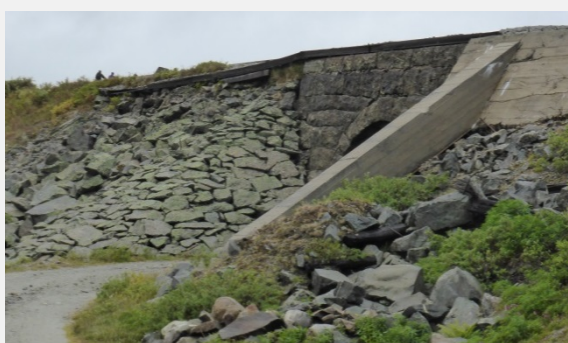
Element nr. 3 Undergang Finsesvingen
