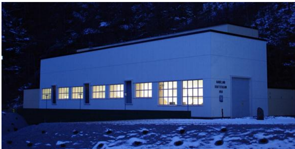
Figur 7. Hardeland kraftverk (foto Haugaland Kraft).
