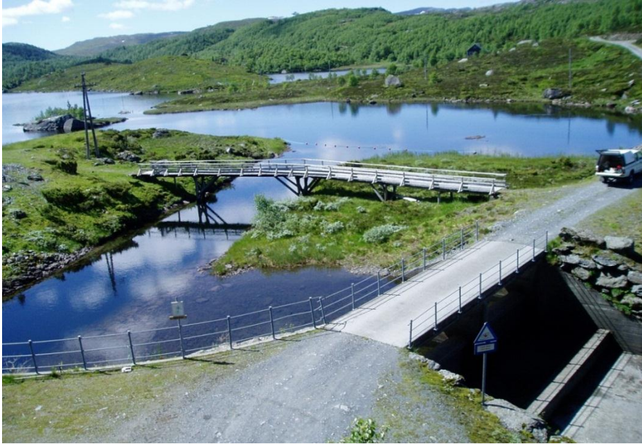
Figur 5. Inntak Hjørnåsvatn (foto Haugaland Kraft).
