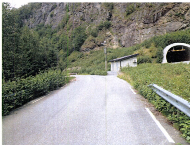
Viser teknisk bygg til Myrkdalstunnelen m/tilkomsveg
