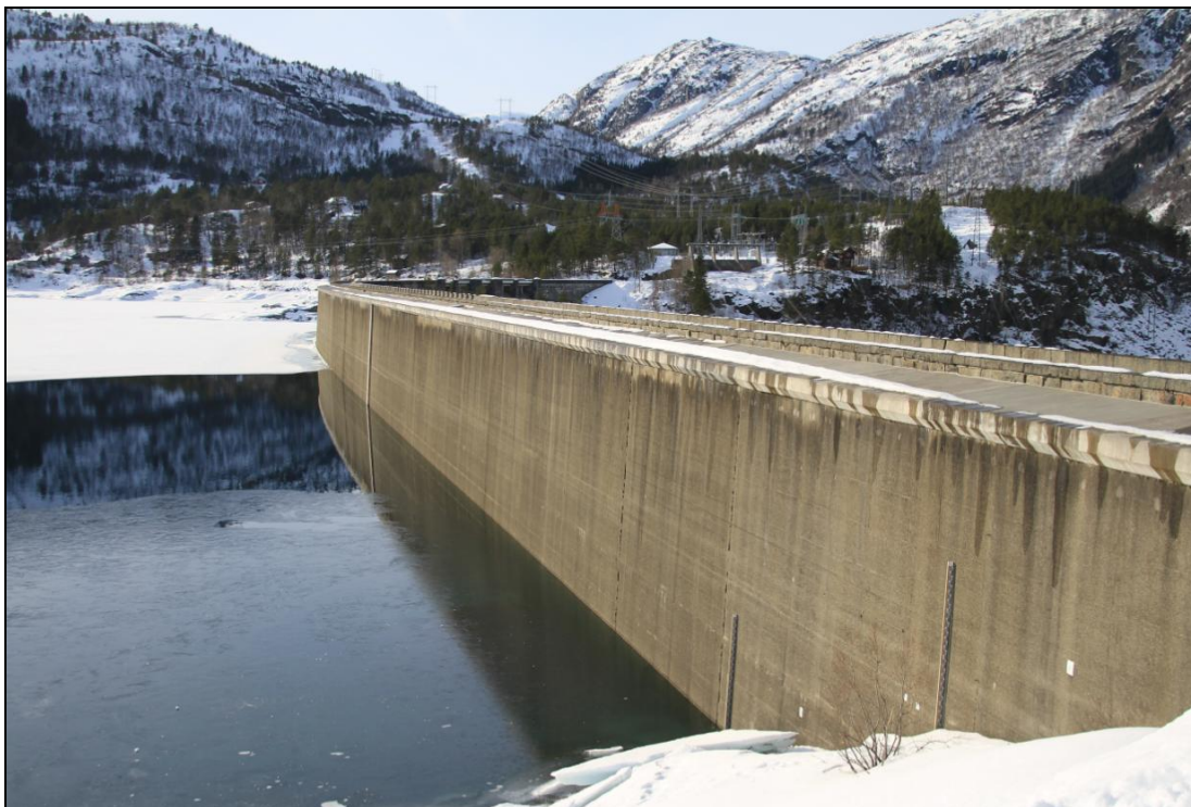
Figur 7. Ringedalsvatnet i Odda er demmet opp av den kjente Ringedalsdammen og har en reguleringshøyde på 92 meter. Forholdene for fisk i et basseng med slikt reguleringsregime er svært problematisk. (Foto 07.03.2013 Torstein Backer-Owe)
