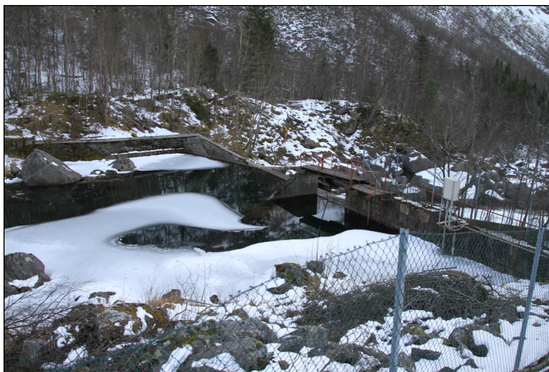
Figur 23. Drikkevannsinntak i Tyssø i Odda. Lenger opp i vassdraget er det utslipp av kloakk som er viktig å rense svært godt, dessuten må det slippes minstevannføring fra vannkraftanlegget lenger opppe for å gi nok drikkevann i elva. (Foto 07.03.2013 Torstein Backer-Owe)
