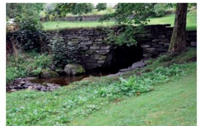
Vegen som gjekk langs austsida av lystanlegget var ein del av postvegen til Christiania. Steinbrua der vegen kryssa Landåsbecken er truleg frå 1700-talet og ei av dei eldste bevarte bruene i Bergen.
