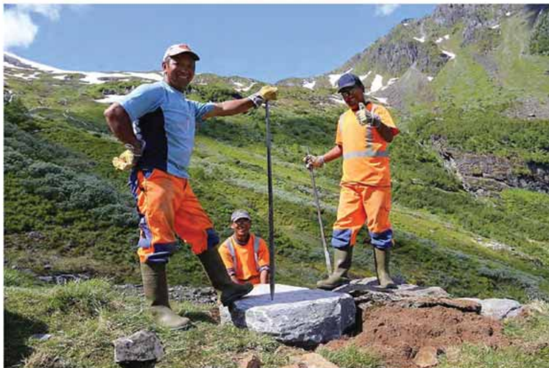
Foto viser bygging av Buførevegen på Reisetet. Foto: Per K. Måkestad, Buførevegens vener.
