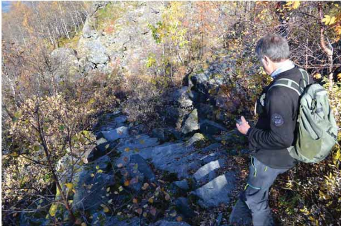
Bilete / GPS 6/7: Her har det tidlegare gått ras, treppene her er relativt nye (15-20 år). Her bør treppene reetablerast betre. Aktuelt med tiltak T6 , T7 og T8 . Foto: HFK
