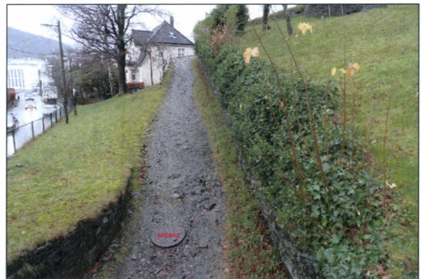
Foto: 24_4A 10,51m, Inspeksjon fullført i 640942
