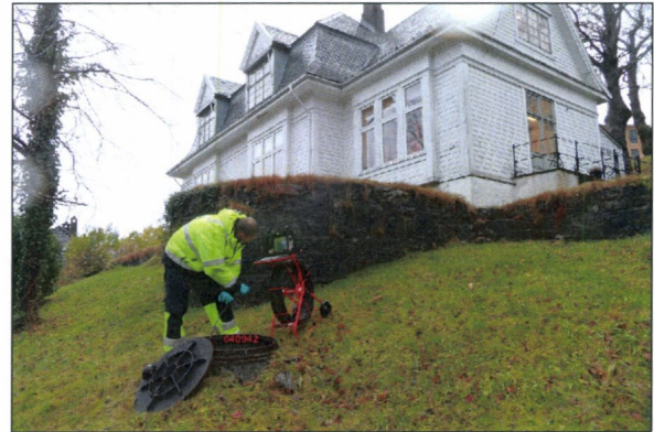
Foto: 24_1B 0m, Start inspeksjon -
