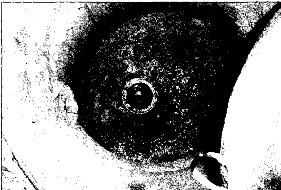
Foto: 25_2A 0,38m, Retningsending 06 Kl., Prefabrikkert bend
