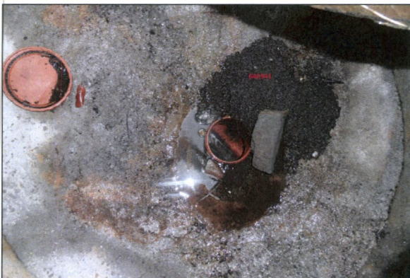
Foto: 24_2A 0,23m, Retningsending 06 Kl., Prefabrikkert bend
