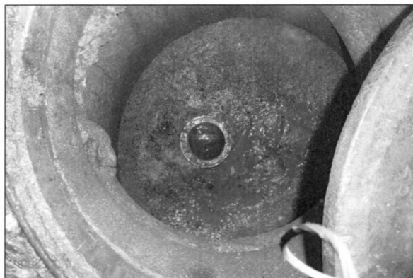
Foto: 24_4B 10,51m, Inspeksjon fullført i 640942
