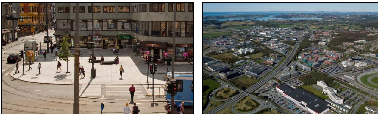
Figur 0.11. Nærings- og handelsområder i by/tettsted har som oftest en annen arealutnyttelse, struktur og utforming enn områder med tilsvarende funksjoner utenfor tettstedene. Foto: Nasjonal gåstrategi (Statens vegvesen 2012).
