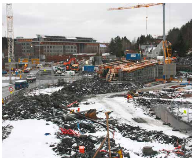
Bygging av bru over Ytrebygdsvegen. Foto: Bybanen Utbygging AS.
