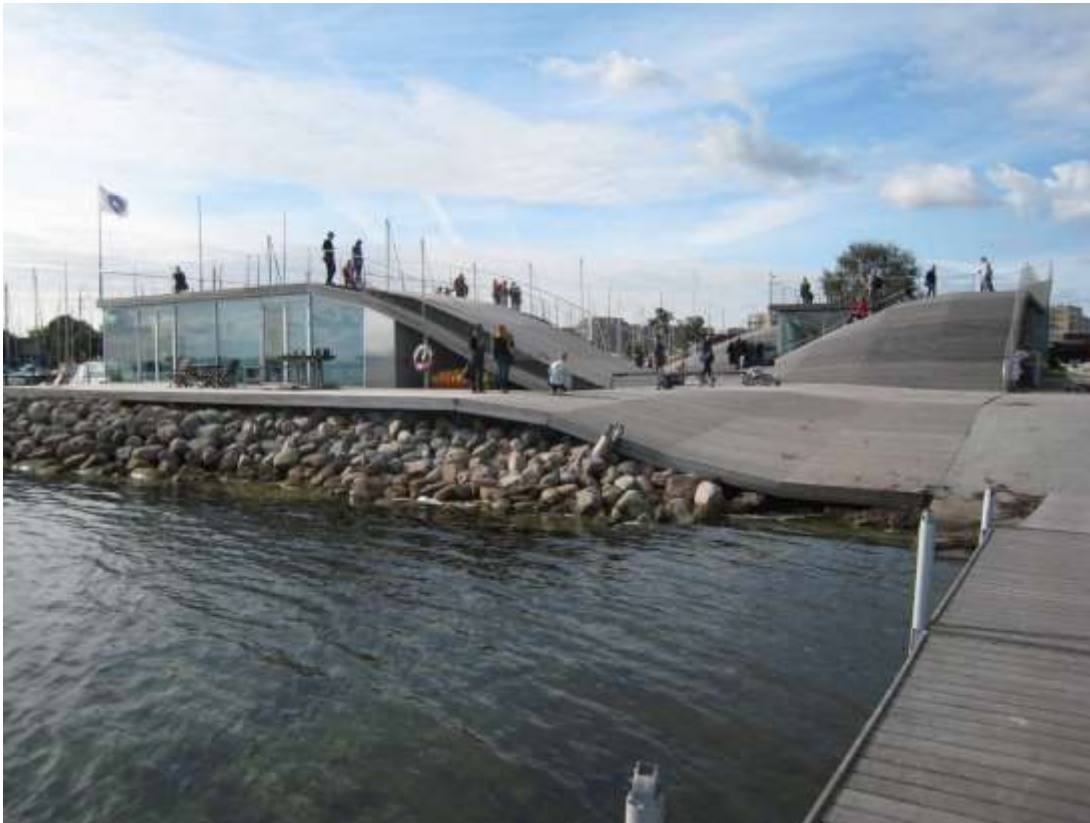
Figur 54. Bygg i strandsona kan vera ein del av strandsona. Dette er eit klubbhus for ei båt foreining i København.
