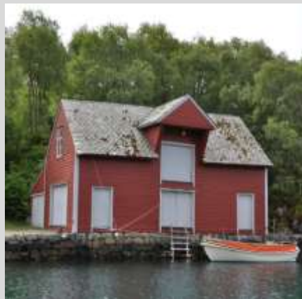
Figur 21. Sjøhus med fiskebruk. Bygget er konstruert for lagring av utstyr og reisskap og for greiing av garn og arbeid knytt til fisket. Er dette eit naust eller eit næringsbygg?
