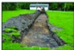
2013-054-007.JPG Sjakt 1 sett mot N
