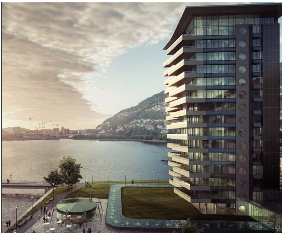
Figur 8.11. Leilighetene (sett fra sør) har store balkonger som strekker seg rundt bygget. Mot syd har balkongene energirekkverk som produserer varme. (Illustrasjon: MIR).
