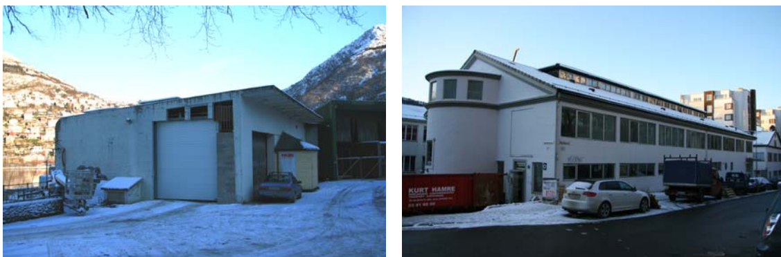
Figur 17. Restene etter DANO-bygget til venstre, Møllendalsveien 63a til høyre.
