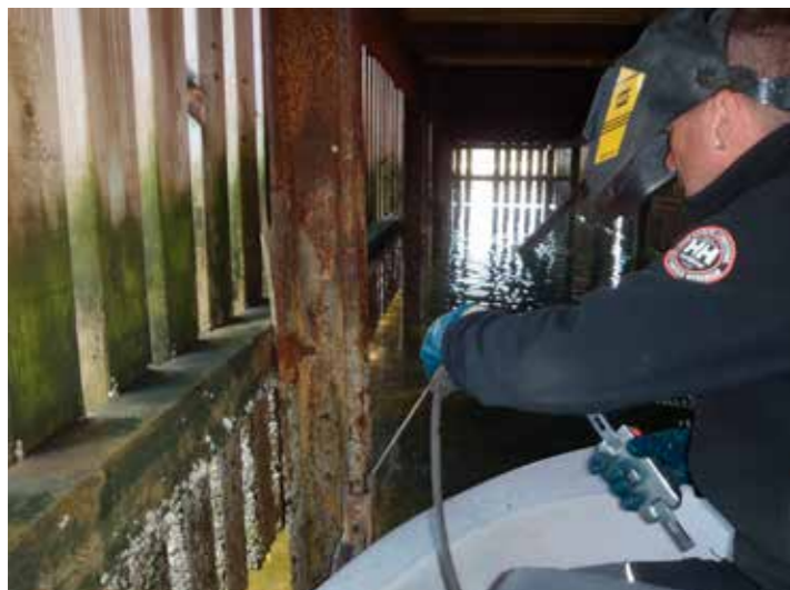
Montering av nye sinkanoder på kaien i Skageneset i Radøy.
