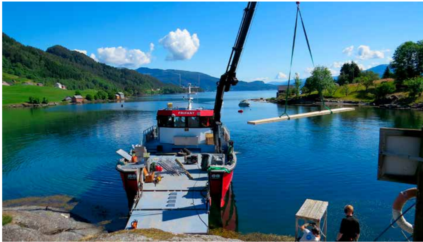
Nytt stupebrett og nytt friluftsområde, Småholmane i Kvam.
