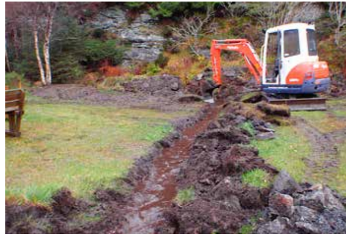
Dreneringsarbeid i Øksnes i Austrheim.
