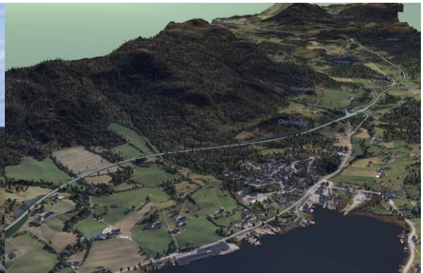
Kryss/trase ved Espelandssvingene
