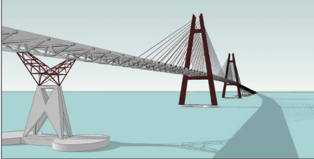
Figur 30 Døme på flytebru med seglingslei midtfjords
