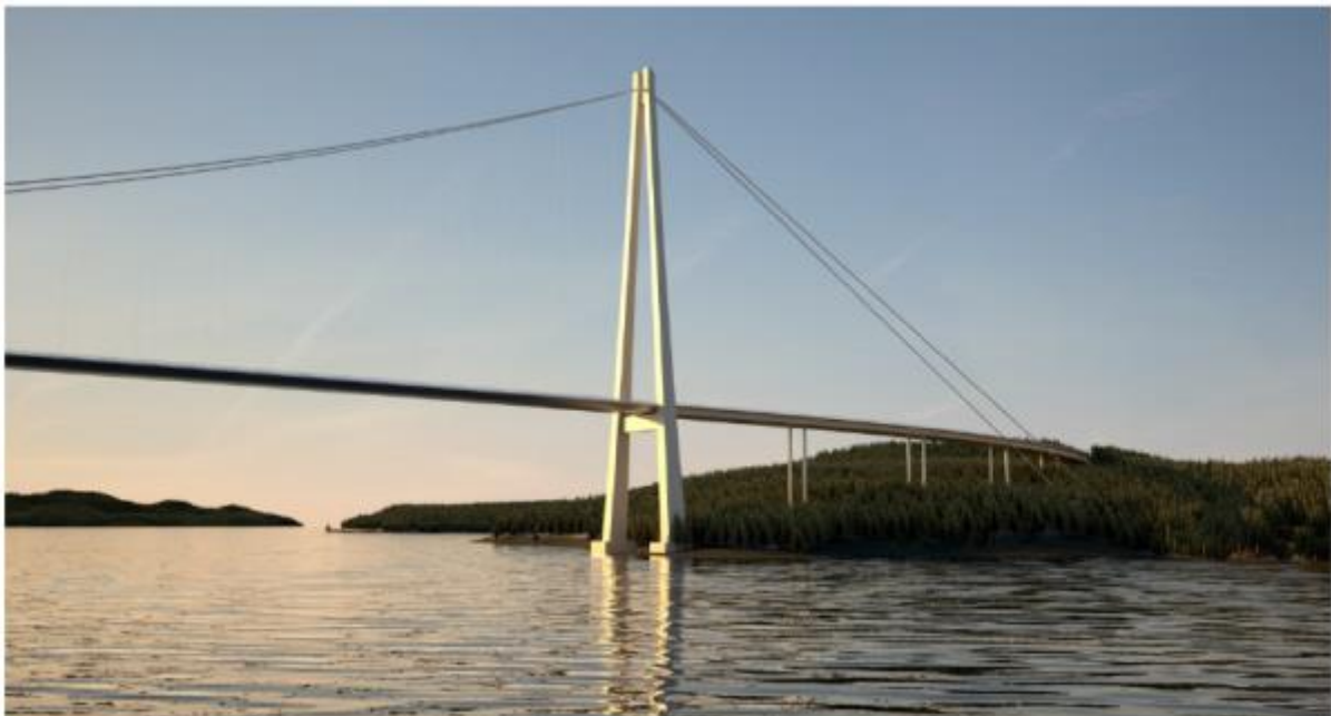
Figur 27 Tårn ved nordre kryssing – same prinsipp ved alle kryssingsstadane
