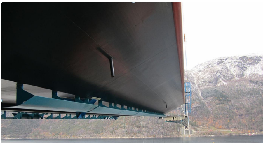
Foto: Ledeskovler på undersiden av Hardangerbrua (fra montasjen)
