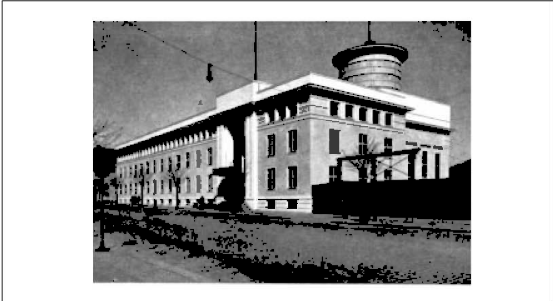
Fig. 19: Bergens Lysverker, Fasade mot Lars Hillesgt.
