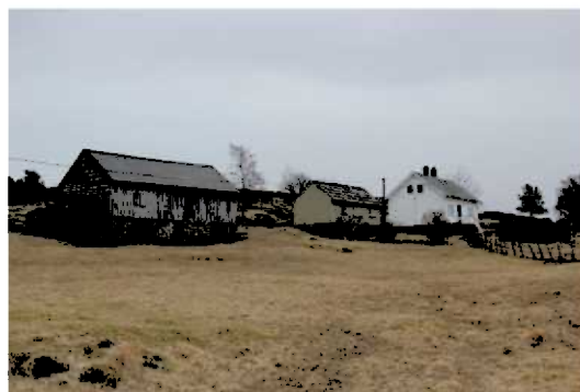
Våningshus, uthus og løe, 58.6. Gardsmiljø.
