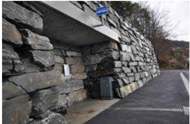
Opprusta haldeplass Foto: Statens vegvesen
