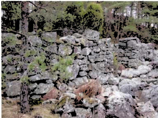
Grunnmur frå gamlesaga flytta i 1920
