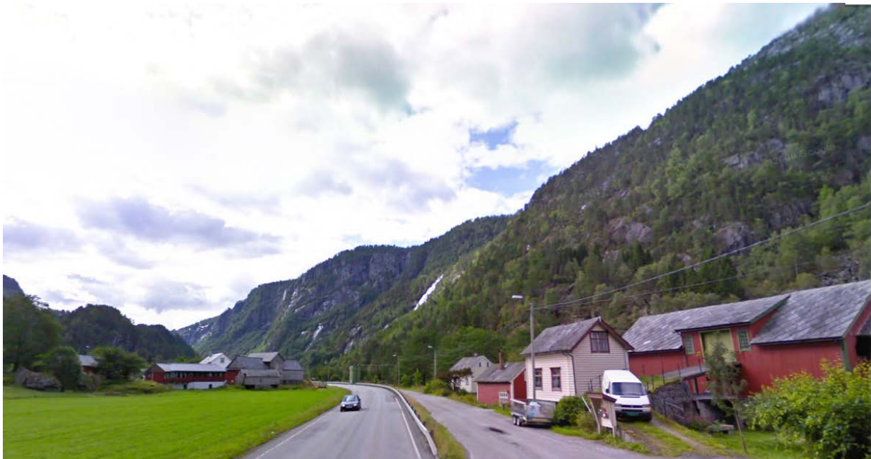
Figur 13: Når ein nærmar seg Hildal finn ein det næraste ein kjem ein gang- og sykkelveg innan planområdet. Her er skilr ei innkøyrsløse frå riksvegen gradvis over til å bli gang- og sykkelveg mot Hildal. Det er ingen kryssingsmogelegheit over/under riksvegen.
