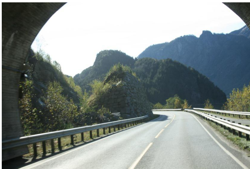
Figur 24: Dagens veg langs Sandvinvatnet
