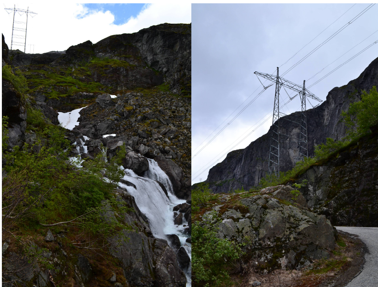
Figur 5 420 kV-kraftleidninga Sima-Samnanger i øvre delen av Austdalen. Austdøla i middels vassføring til venstre. Frå synfaringa 16.07.15.
