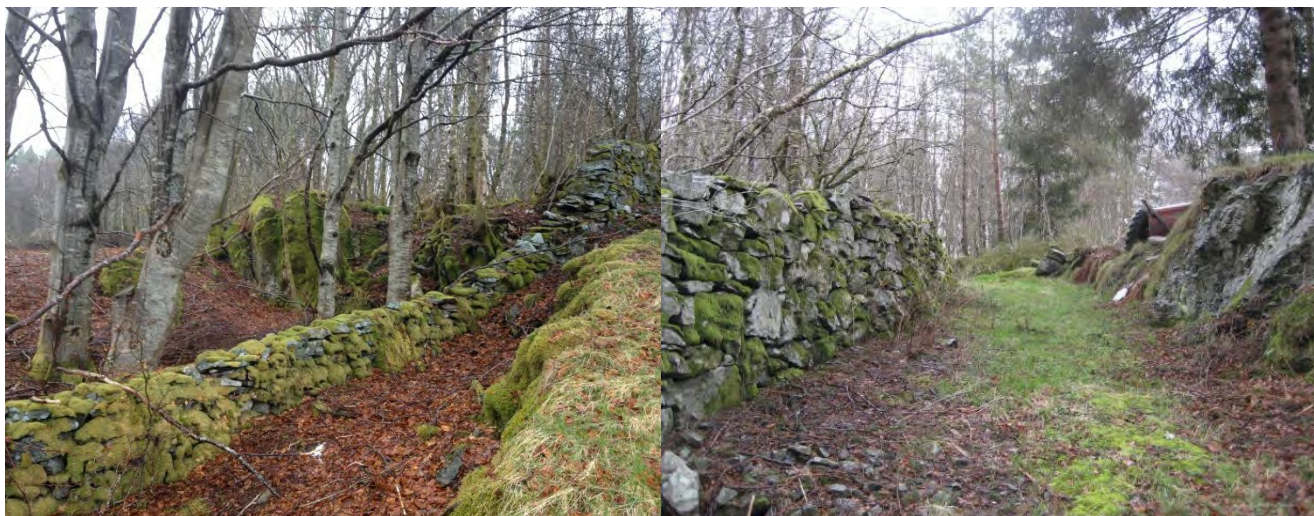
Steingard mellom bnr 1 og bnr 34, vestre del (B)
