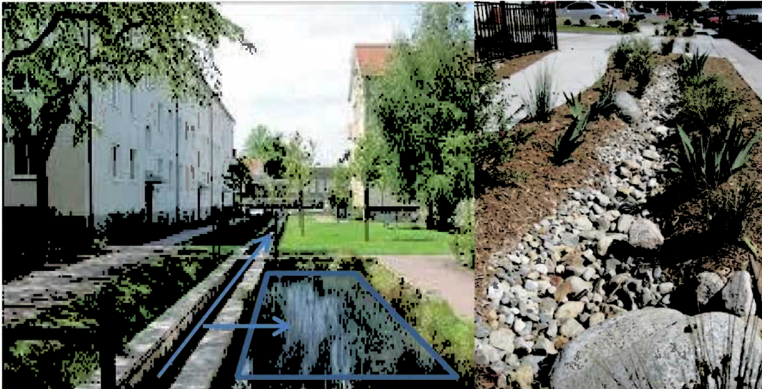
Figur 9 Til venstre vises betongkanal ved bebyggelse. Kanalen har utløp på siden til område for midlertidig oversvømmelse og infiltrasjon. Bildet til høyre viser steinsatt infiltrasjonsgrøft.
