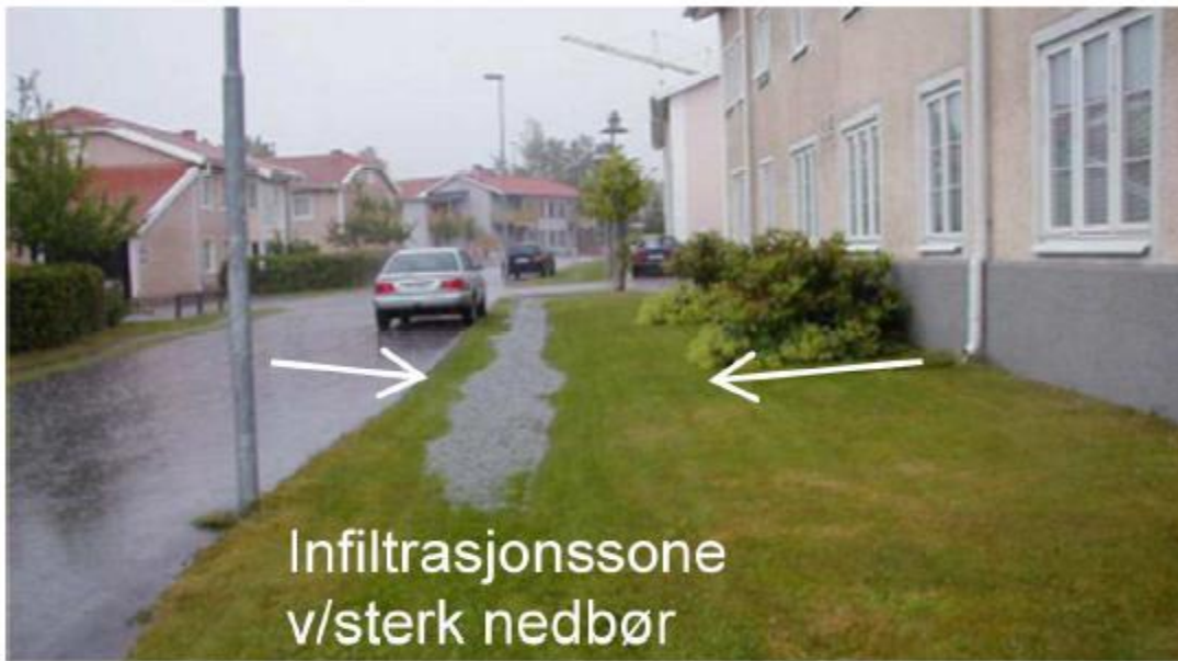
Figur 10 Infiltrasjonssone mellom veg og bebyggelse. Kilde: Veileder for lokal overvannshåndtering, Rogaland Fylkeskommune/Jæren vannområde
