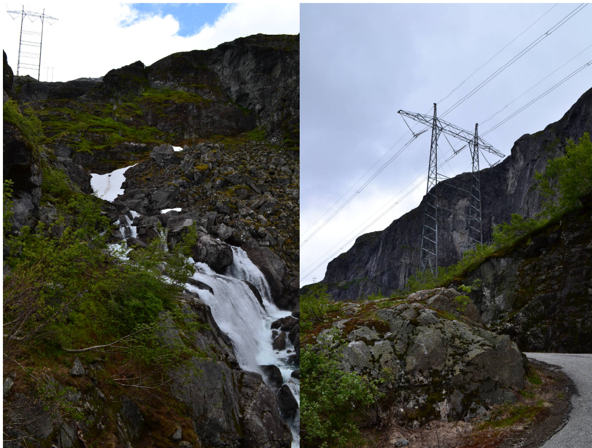
Figur 5 420 kV-kraftleidninga Sima-Samnanger i øvre delen av Austdalen. Austdøla i middels vassføring til venstre. Frå synfaringa 16.07.15.
