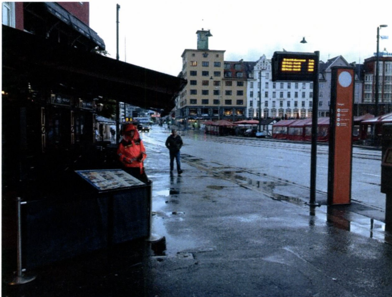
Bilde 5: Bilde fra befaring som viser at inngjerdingen går litt for langt ut (person i vegvesen-jakke står ved punktet som ivaretar 4 meter bredde for gangareal. Markisen henger langt utover grensen.
