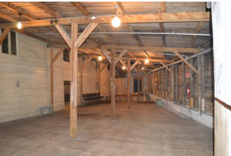
2. etasje, tilbygget på nordsida sett mot vest. Til v. ytterveggen på den opphavlege boden
