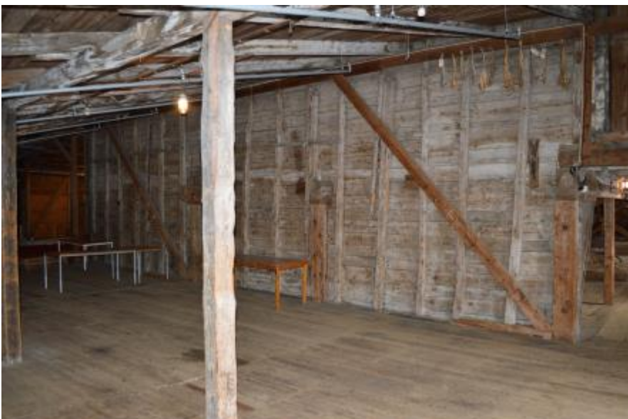
2. etasje, tilbygget i vestenden sett mot nordaust og vestveggen i den opphavlege boden
