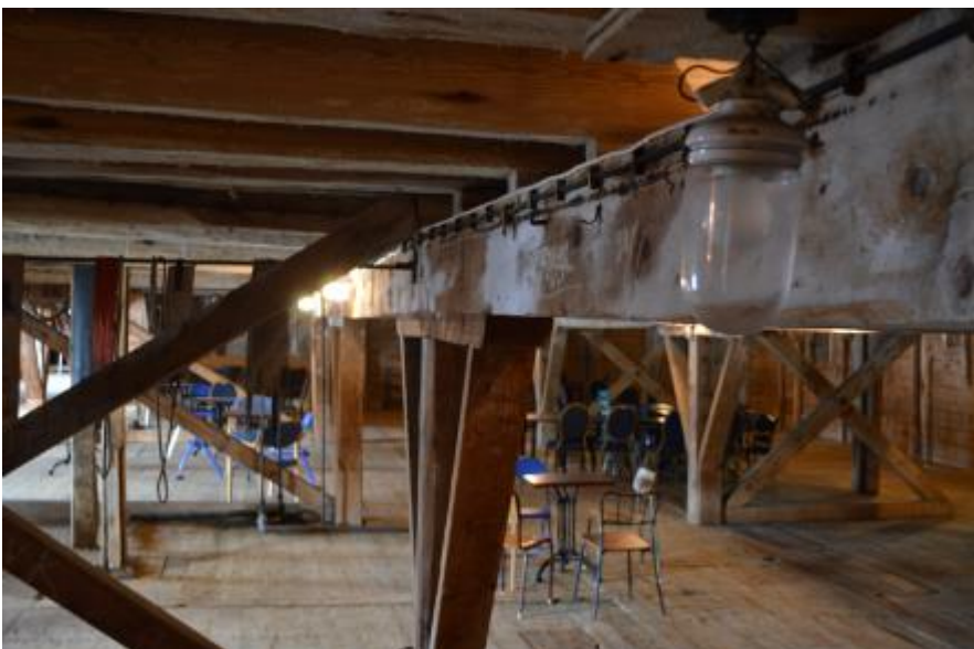
2. etasje, hovudrommet i sjølve boden sett mot vest.
