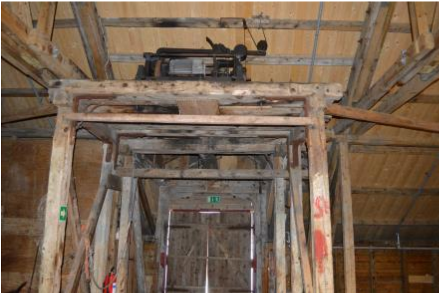
Loftet, den austlege vindearka sett mot sør
