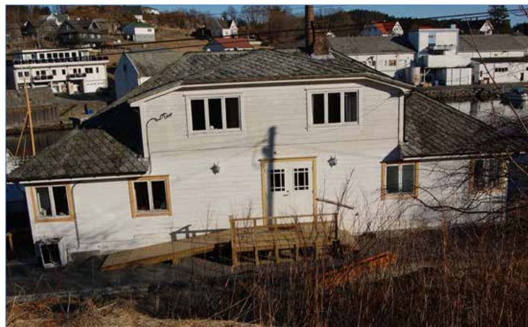
Opprusta inngangspart på Bergslagen våren 2013.
