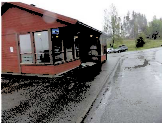
Figur 36: Venterom og bussholdeplass.
