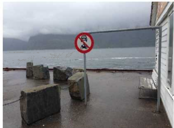
Figur 42 Tydelig markering av kaikant mangler på en del av strekningen mellom venterom og ferjekai.
