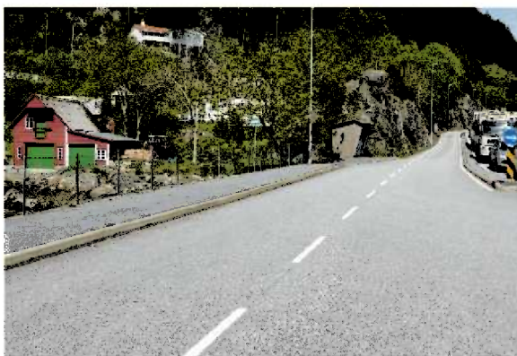
Figur 10 Lehus er plassert feil i forhold til
