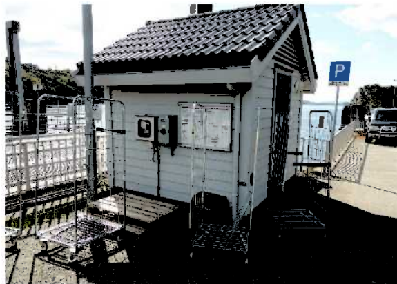
Figur 56 Traller og en pall gjør ruteinformasjonen mindre tilgjengelig
