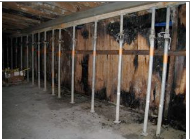
Foto: IMG0700.jpg. ET. 11.12.2008. Innvendige støtter i 1 etasje i bod SJØ
