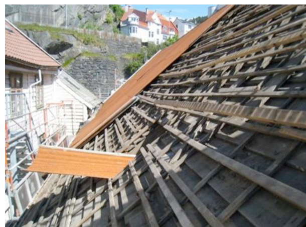
Rensking av taket. Bølgeblikk og mange avrettingslag med lekter. Mot bod 16.
