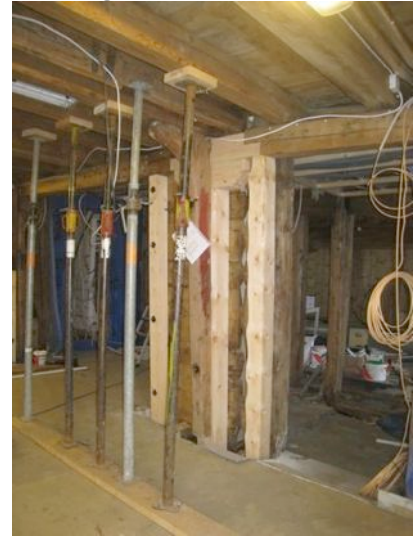
Stolpeverket reparert / fornyet og restene av lafteveggen er stabilisert.
