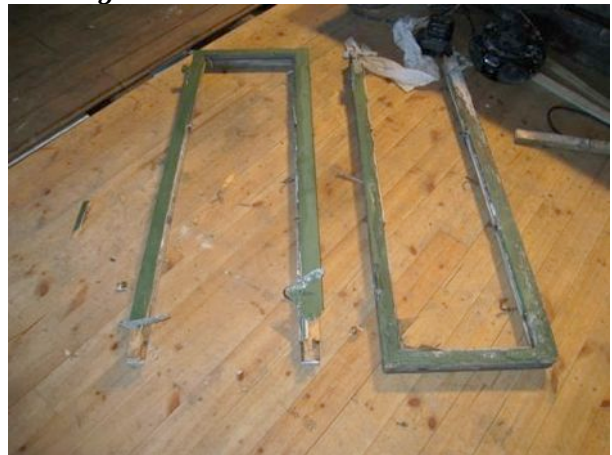
Vindusreparasjoner. Demonterte vindusrammer fra bod 14SJØ, for reparasjon/fornyelse av rått bunnramme.
