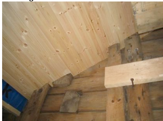
Krabbing panel skråtak mot opplengere mv i rom 301, mellombygget.
