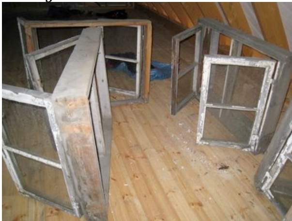
Vindusreparasjoner. Diverse vinduer fra bod 15 komplett med karm demontert for reparasjon og gjenbruk.
