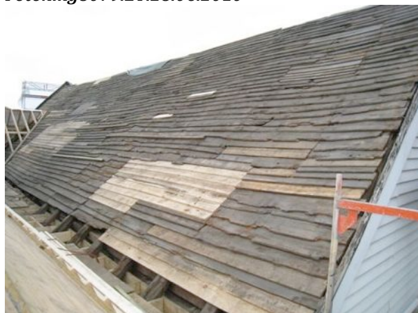
Gammelt sutaket ferdig reparert. Mot Mellombygget. I nedre billedkant ny flat sløys.
