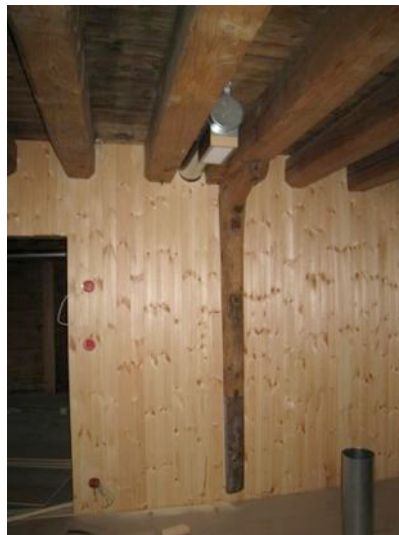
Rom 210. Nytt arkivrom. Krabbing veggpanel mot bjelker og bordtak og knær selv i et underordnet arkivrom. Ny avtrekkskanel nesten komplett montert av Albeslag as. Glatte stålrør, ikke spiro-rør.
