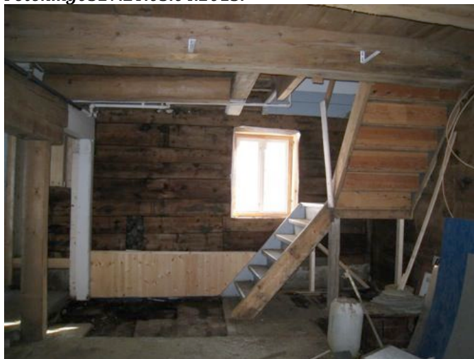
Gavlveggen mot gaten. Sett fra rom 107. Frilagt laftevegg. Nytt vindu i gjenfunnet gammel vindusåpning med rester av defekt vindu. Lav brystning skjuler nyere teglmurt sokkel, sannsynligvis fra 1920.
