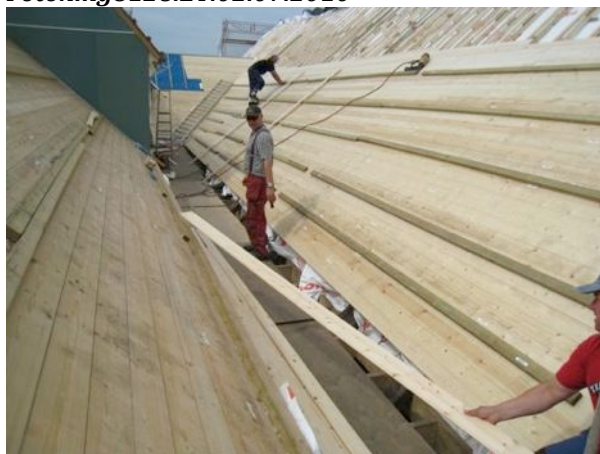
Tekking. Bod 14 til venstre. Bod 15 til høyre. Isola soft vindspærre mot gammelt sutak, derpå leker for lufting og diverse avretting for pannetekking. Pløyd bordtak under montering. NB Rektene på foto er kun for tilkomst.
