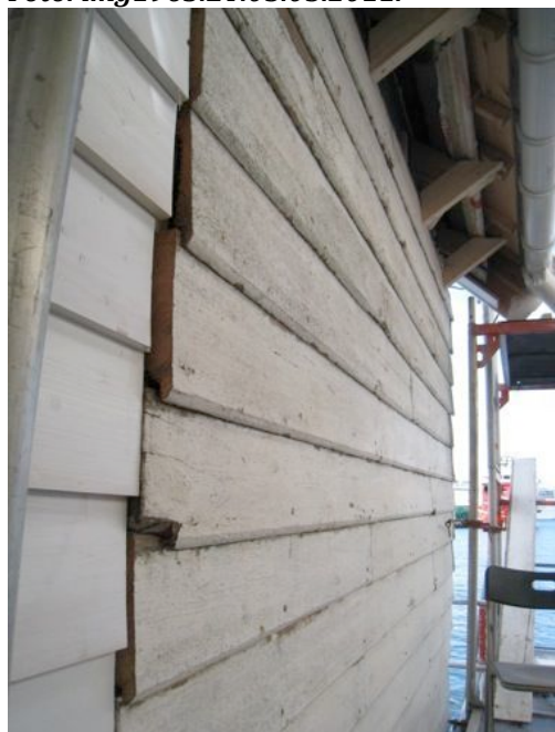
Gjenbruk gammel kledning på yttervegg mot bod 16. Kledning eldre enn 1920.
