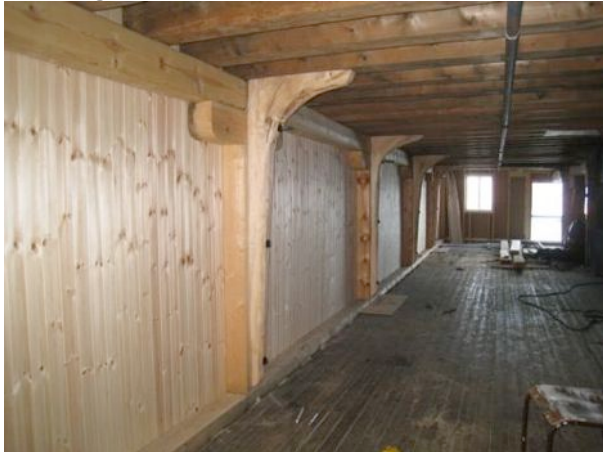
Innfesting av nye knær med smidde bolter, skiver og firkantmutre og smidde spiker.
