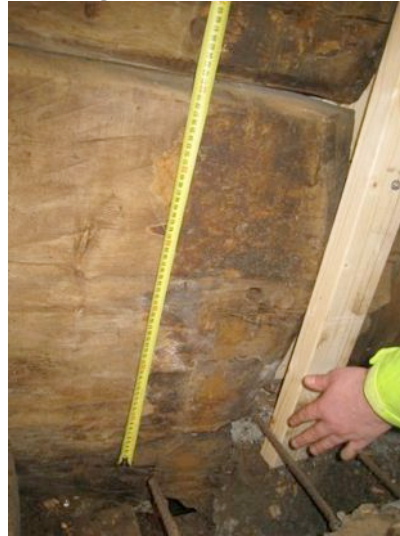
Gammel bunnstokk laft 64 cm høy. Skal få stå frilagt.
