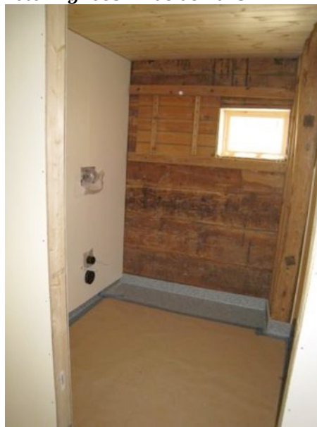
Skyveluker og laftetømmer i behold synlig på nytt verksteds-toalett.
