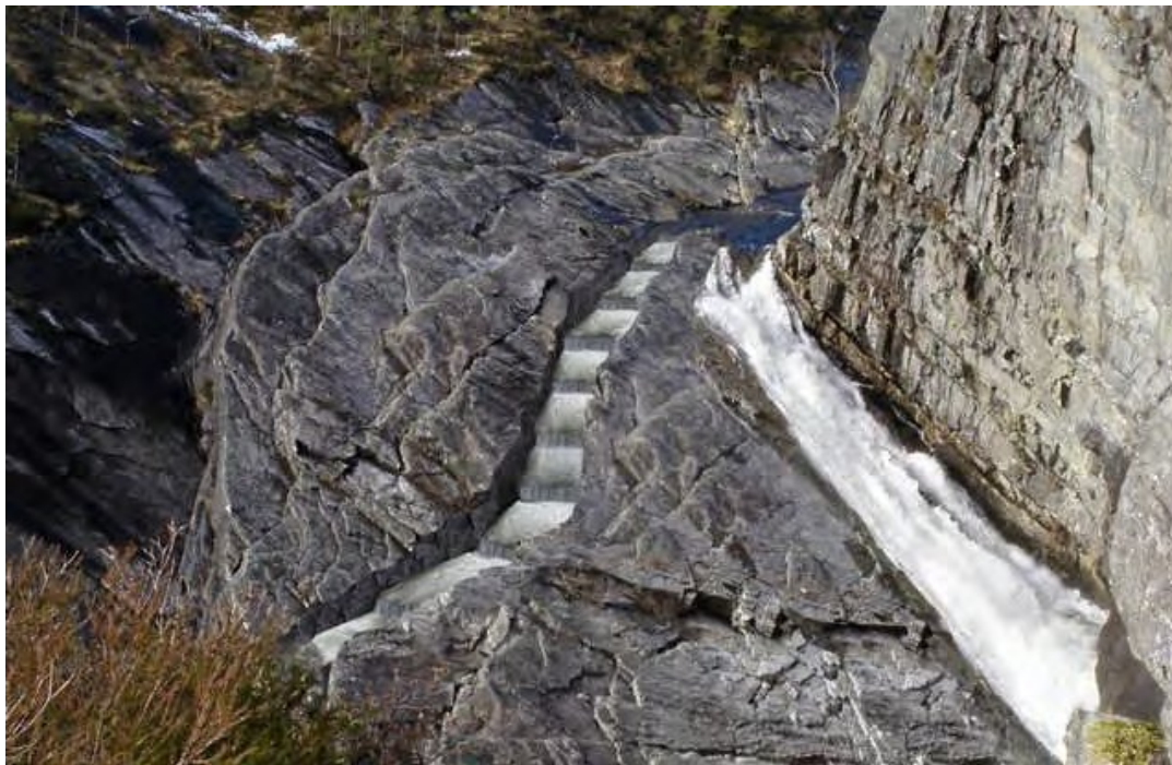
Figur 3-8 Laksetrapp i Raudfossen i Ekso vart bygd i 2010/2011. Foto: BKK sine heimesider.
