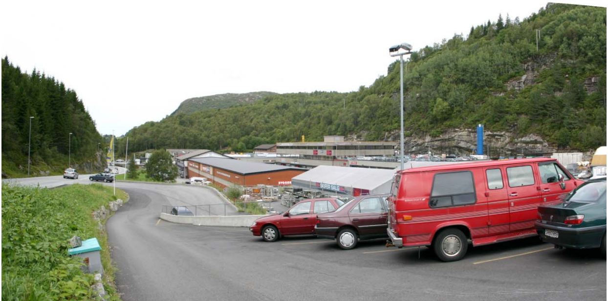
Østre avkjørsel med fordelingsveier til forskjellige terrengnivå. Salhusvegen til venstre.
