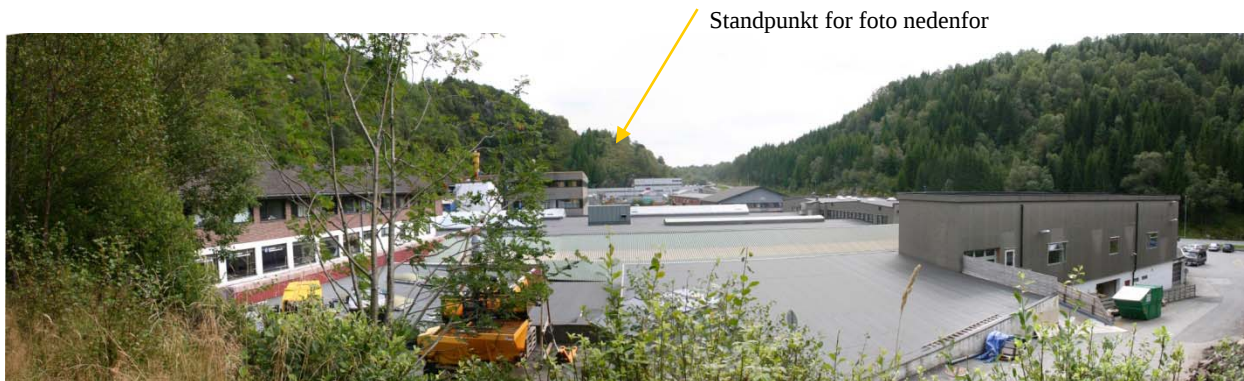
Oversiktsbilde fra nordvest med vestre innkjørsel i Salhusvegen ved høyre billedkant
