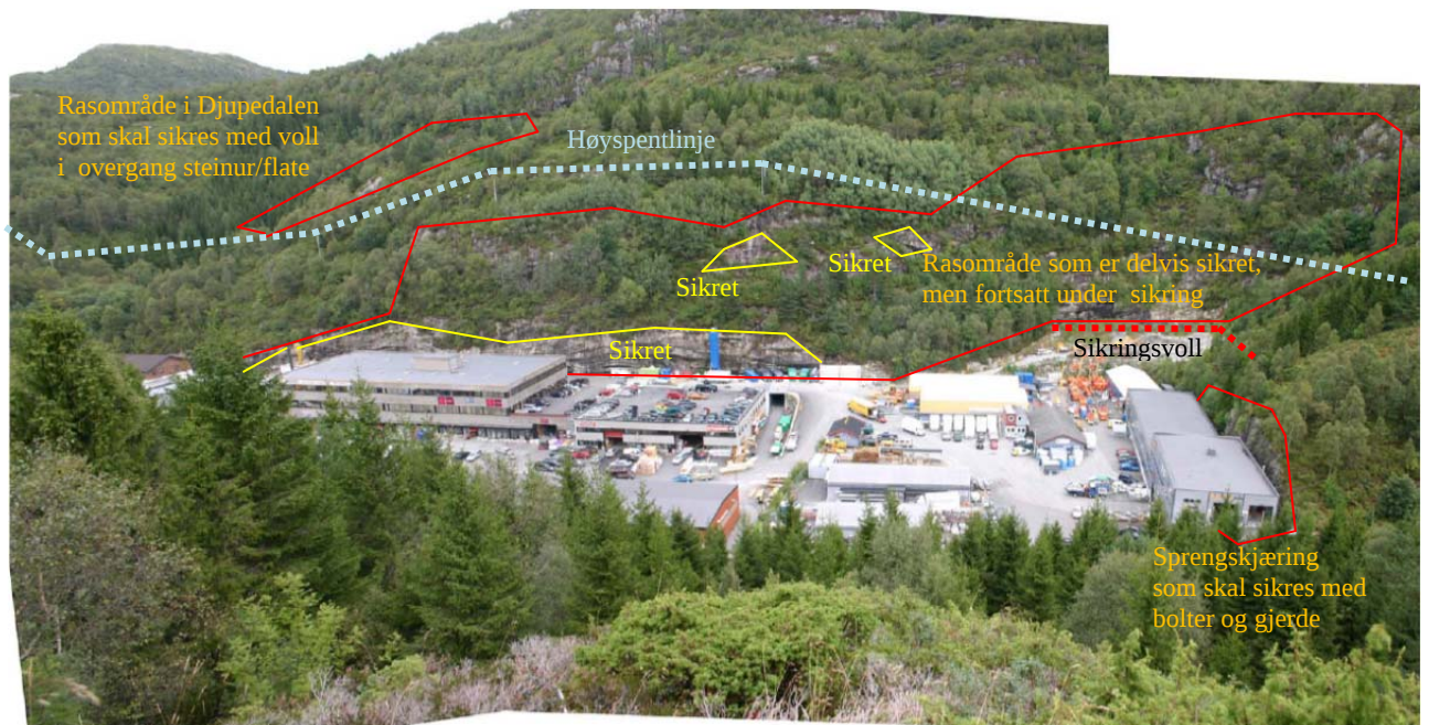
Oversikt over rasområder som er sikret/skal sikres.
