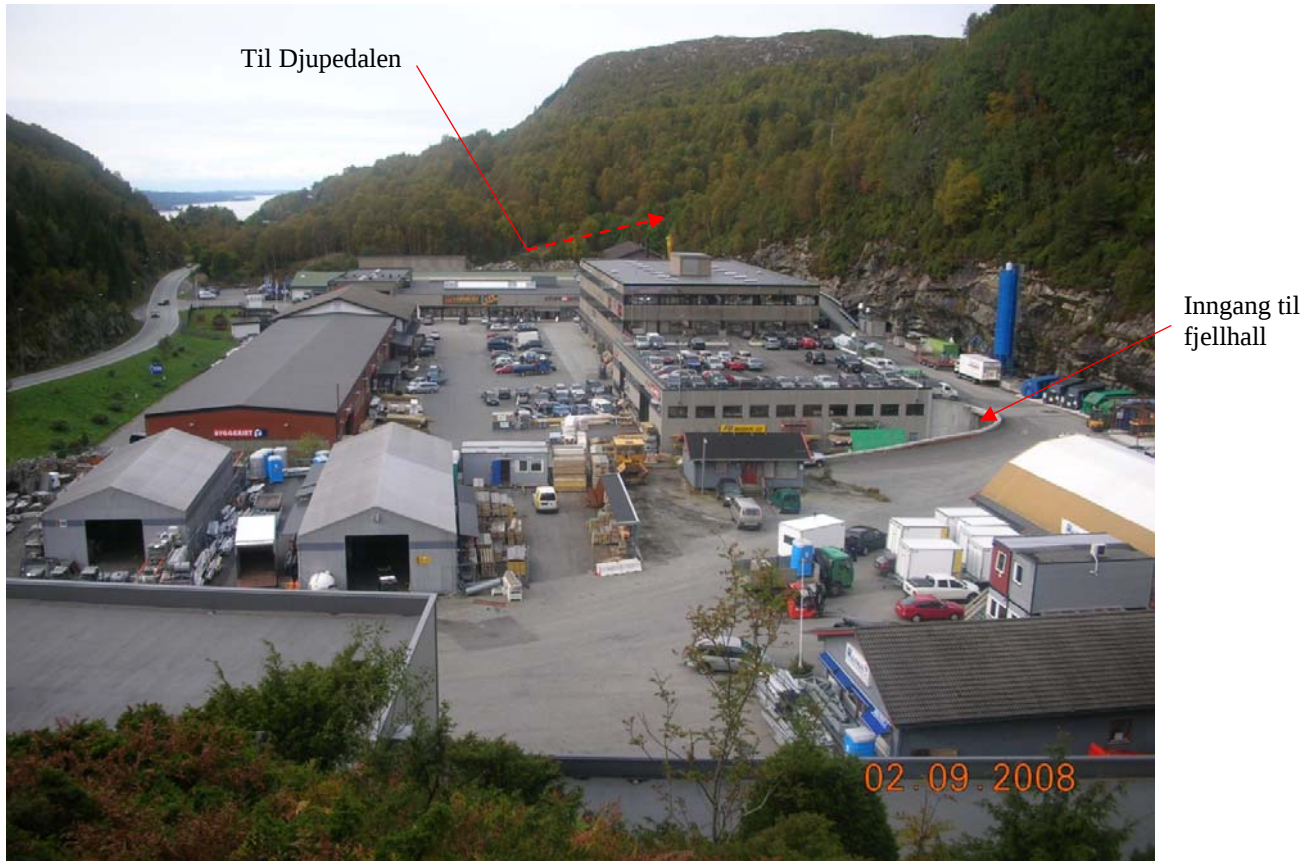
Utsikt over den utbygde del av området, Salhusvegen til venstre. Djupedalen inn til høyre (stiplet pil).
