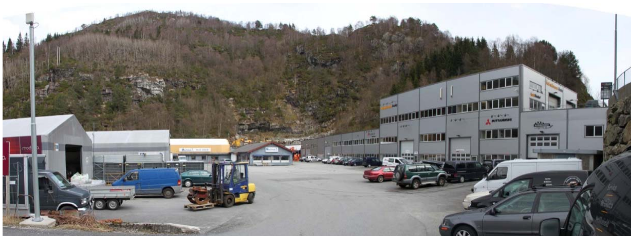
Søndre del av området med verkstedsbygg. Fjellnabb til venstre over plasthaller er sikret med bolter i senere tid (se nærbilde side 20).
