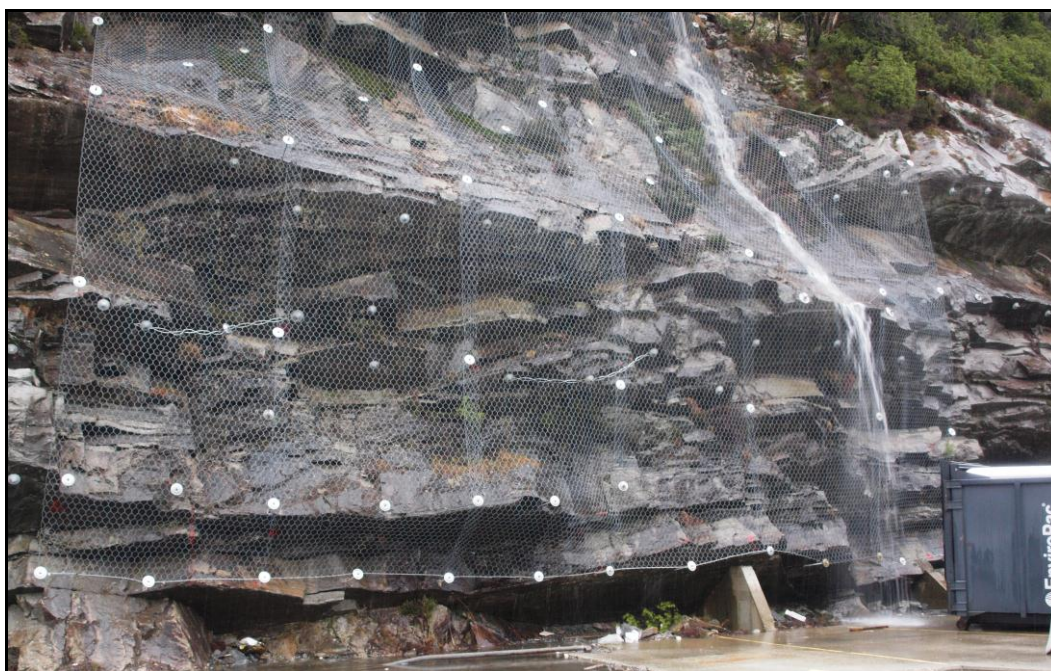
Fig 14. Sikret område nordøst for bygningsmasse.
