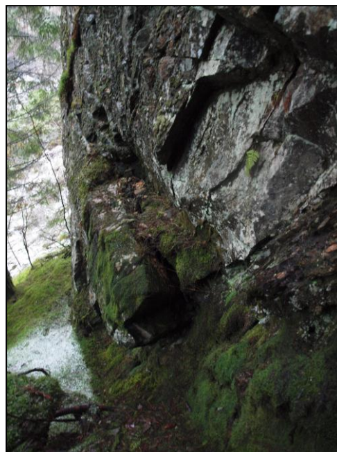
Fig. 16. Skrent må boltes.
