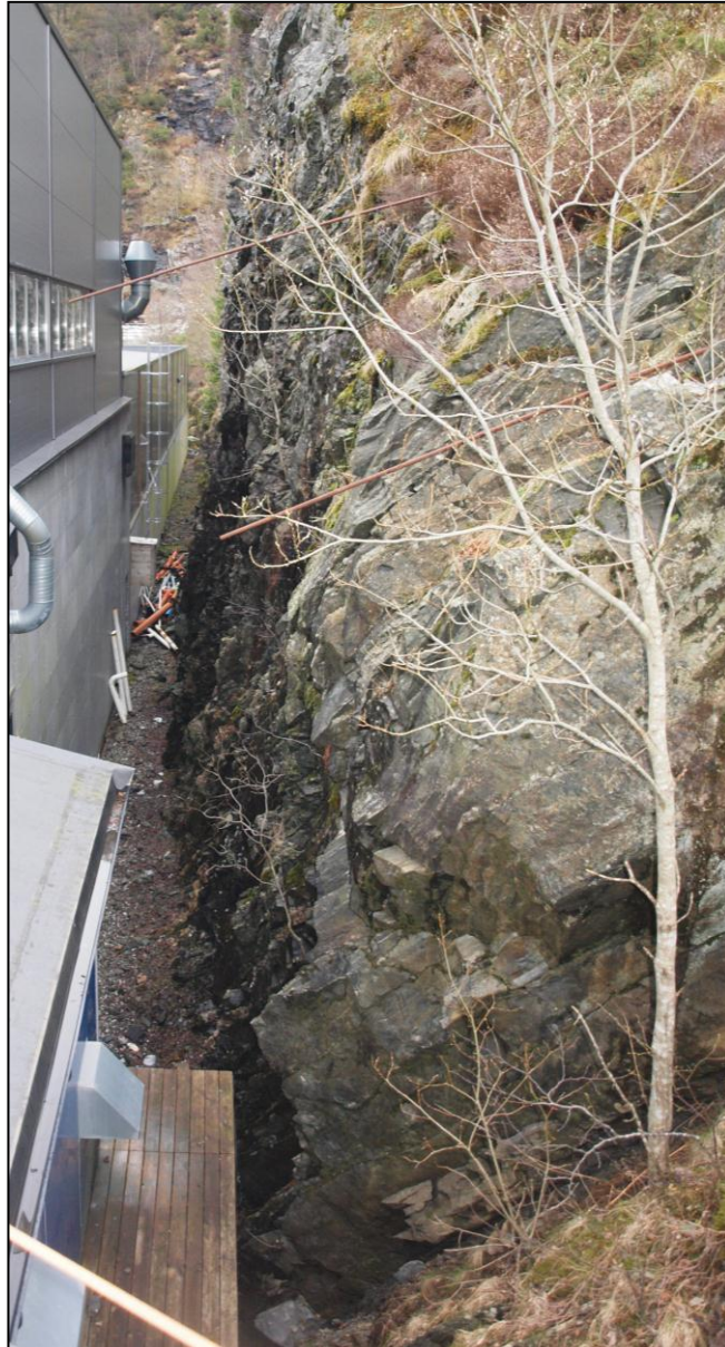
Fig 7. Utsprengt skrent ved verkstedsbygg i sørøst.
