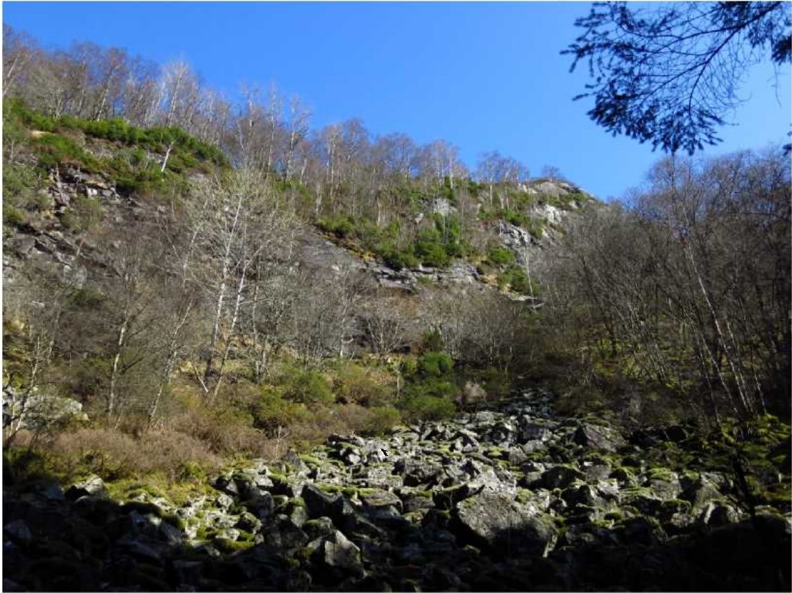
Bilde 5. Ustabilt berg med stor fare for steinsprang nordøst for planområdet i Djupedalen. Her anbefales etablering av skredvoll.
