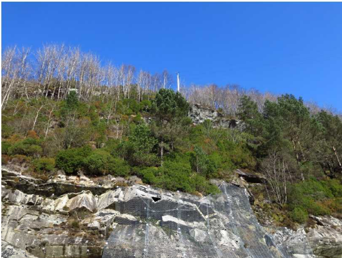
Bilde 3. Steil bergskråning øst for planområdet, se punkt 3 i figur 2 i notatet. Deler av berget er sikret med bolter og steinsprangnett.
